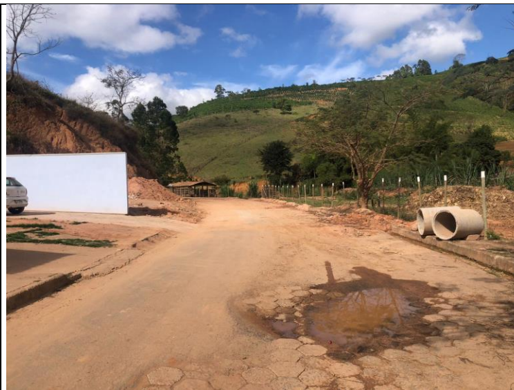
Descrição: Rua Lopes Abelha, Local do término do calçamento existente e início do calçamento a executar.
